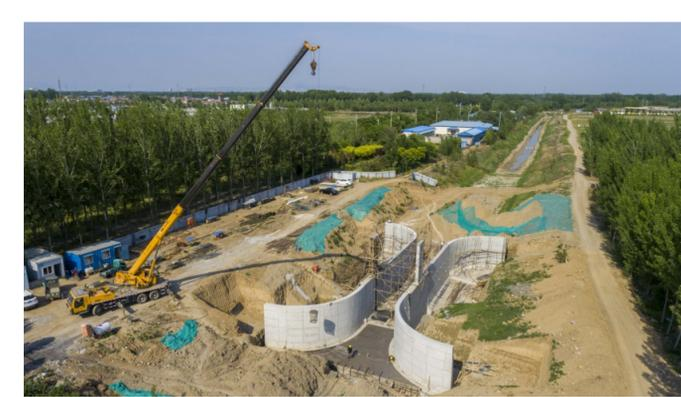
作为我县民生实事工程和水生态治理工程之一的一千南引工程目前正在加紧建设。焊接圆弧挡墙、搭建消力池挡墙、浇筑消力池挡墙、清理浆砌石护坡基础……工人们全力抢抓水利项目建设进度,力争早日竣工惠民。工程建成后,将有效削减污染物入河量,改善流域水质,提升流域环境质量,助力乡村振兴和农村人居环境整治。 何赛 文/图
