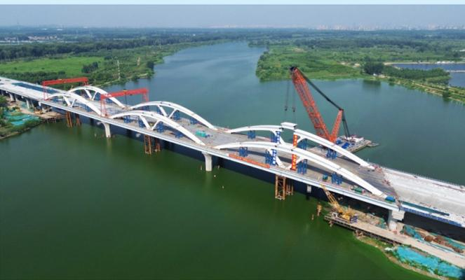
图为厂通路潮白河大桥主桥拱肋最后一个节点精准落位。李志新 图
