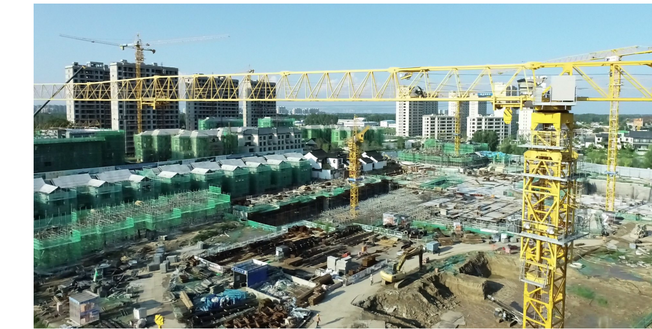
图为国京戏剧文化交流中心东区项目建设现场 韩磊 摄
